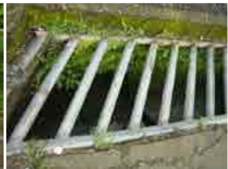
Vista sumidero de aguas lluvias y tubería de aguas residuales
