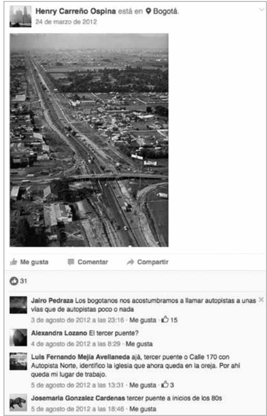
Figura 3.4. Post puente calle 170.
