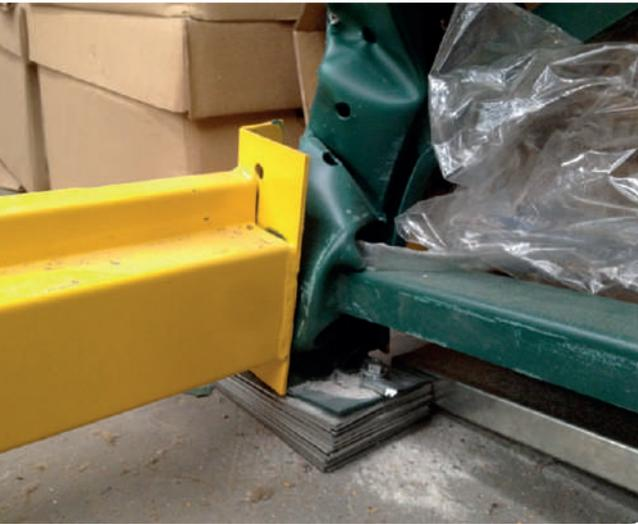
Figura 56. Aplastamiento en columna de estantería. Inicio del colapso. Fuente: elaboración propia.
