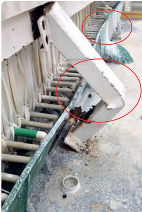
Figura 35. Estructura con deformación plástica como consecuencia de una falla por corrosión. Fuente: elaboración propia.
