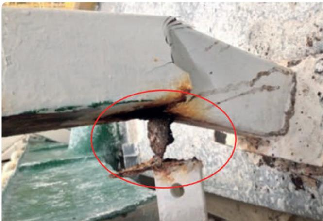
Figura 34. Falla en estructura por corrosión general.
